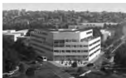
SUCY EN BRIE ZAC LES PORTES DE SUCY II 2020 - En cours ATREALIS PROMOTION Immeuble de bureaux de 6.200 m 2 SDP
