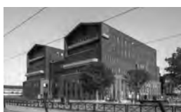
NANTES OUCHE BURON 2017 - 2021 ADIM OUEST Siège d'Orange Immeuble de bureaux de 10.200 m 2 SDP
