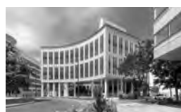
RUEIL-MALMAISON LA ROTONDE 2016 - 2021 BNP PARIBAS IMMOBILIER Immeuble de bureaux de 11.000 m 2 SDP
