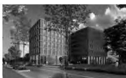
MONTPELLIER CAMPUS CAMBACERES 2019 - 2023 LINKCITY / CFC Immeuble de bureaux de 8.200 m 2 SDP
