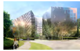
MONTIGNY-LE-BRETONNEUX AV. NICÉPHORE NIÉPCE 2013 GECINA Immeuble de bureaux de 13.831 m 2 SDP
