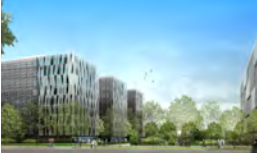
MONTIGNY-LE-BRETONNEUX QUARTIER DU PAS DU LAC 2011 GECINA Deux Immeubles de bureaux de 47.000 m 2 SHON
