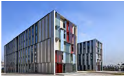
AMIENS ZAC DE LA VALLÉE 2005 - 2009 SODEARIF Immeuble de bureaux de 10.000 m 2 SHON
