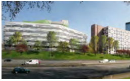
BAGNOLET RUE PARMENTIER 2010 FONCIERE DES REGIONS Réhabilitation lourde et extension d'un immeuble de bureaux de 14.500 m 2 SHON
