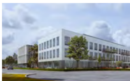
MERIGNAC INNOLIN 2017 - en cours ALTAREA COGEDIM Immeuble de bureaux de 15.306 m 2 SDP
