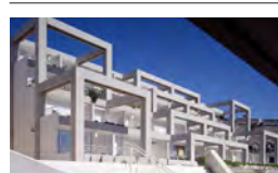
SÈTE 1988 - 1998 DEVIQ Promotion & Office Public d'HLM de la Ville de Sète 164 Logements «libres» et 84 logements sociaux P.L.A.
