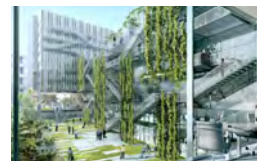
MONTROUGE AV. BROSOLETTE - AV. DE LA MARNE 2015 FONCIERE DES REGIONS Immeuble de bureaux de 20.300 m 2 SDP
