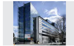
IVRY-SUR-SEINE QUAI JEAN COMPAGNON 2000 - 2007 SOGAM groupe VINCI Siège social de l'entreprise SNC LAVALIN Immeuble de bureaux de 11.500 m 2 SHON
