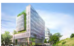
GENTILLY RUE DU VAL-DE-MARNE / RUE VICTOR MARQUIGNY 2016 SODEARIF Immeuble de bureaux de 5.258 m 2 SHON
