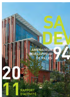
SADEV 94 Rapport d'activité 2011 Immeuble de bureaux Zac Petit Leroy, CHEVILLY LARUE. 2011
