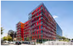
MONTIGNY-LE-BRETONNEUX, AV. DU CENTRE 2006 - 2010 SODEARIF - Siège social de Bouygues Ener- gies et Services Immeuble de bureaux de 11.813 m 2 SDP
