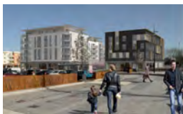
GUYANCOURT ZAC DE VILLARROY, LOT C03 2012 - Livraison 2022 DEMATHIEU & BARD IMMOBILIER Immeuble de bureaux de 2.900 m 2 SHON Commerces de 900 m 2 SHON
