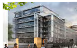
BOIS-COLOMBES ZAC DES BRUYÈRES 2013 - en cours SEFRI-CIME Immeuble de bureaux de 27.000 m 2 SDP
