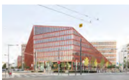
LYON PART-DIEU SITE FLANDIN LACASSAGNE 2014 - Livraison 2020 PITCH PROMOTION / Siège Régional d'Orange. Rénovation et extension d'un immeuble de bureaux de 25.500 m 2 SDP
