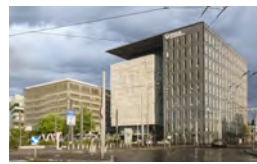
VAULX-EN-VELIN, GRAND LYON AV. DES CANUTS, CARRÉ DE SOIE 2011 - 2013 GROUPE CARDINAL Siège régional VEOLIA Centre Est Immeuble de bureaux de 12.200 m 2 SHON
