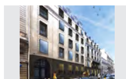
PARIS RUE MIROMESNIL 2018 Primonial Réhabilitation lourde de bureaux 3.000 m 2 SDP
