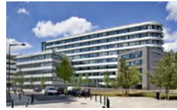
MONTIGNY-LE-BRETONNEUX, AVENUE DES FRÈRES LUMIÈRE 2006 - 2009 CODIC France Siège social de l'entreprise SAIPEM Immeuble de bureaux de 14.600 m 2 SHON
