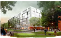
GUYANCOURT AVENUE DU CENTRE 2012 STANDARD LIFE Rénovation d'un immeuble de bureaux de 28.000 m 2 SHON
