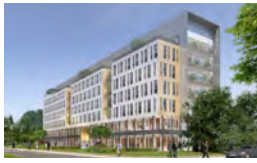
MONTIGNY-LE-BRETONNEUX PROXIMA VI 2019 - en cours CFC Immeuble de bureaux de 7.500 m 2 SDP
