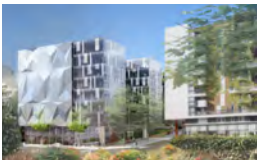
NANTERRE RUE DES TROIS FONTANOT 2013 BNP PARIBAS IMMOBILIER Immeuble de bureaux 14.900 m 2 SDP
